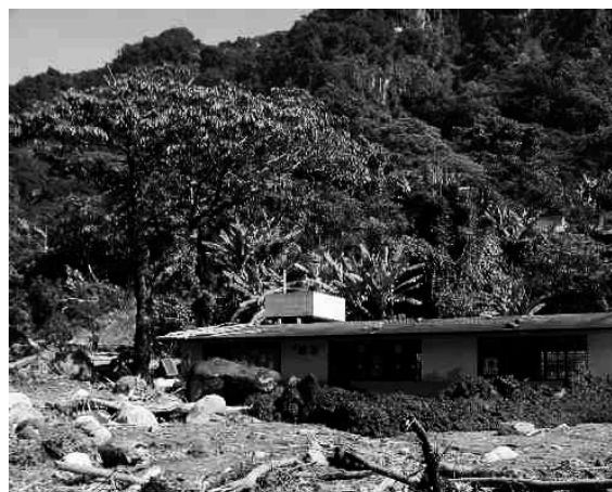
Figura 2. Daño a escuelas por el movimiento del terreno en la ladera norte de la comunidad de Barranca Grande.
