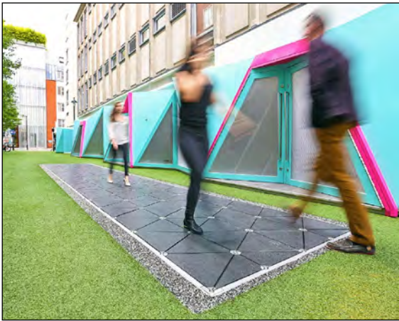
Figura 11. Dispositivos electromagnéticos instalados en el piso que generan energía eléctrica debido al movimiento del tránsito peatonal (PAVEGEN, 2018). Imagen tomada de: http://www.pavegen.com/bird-street .
