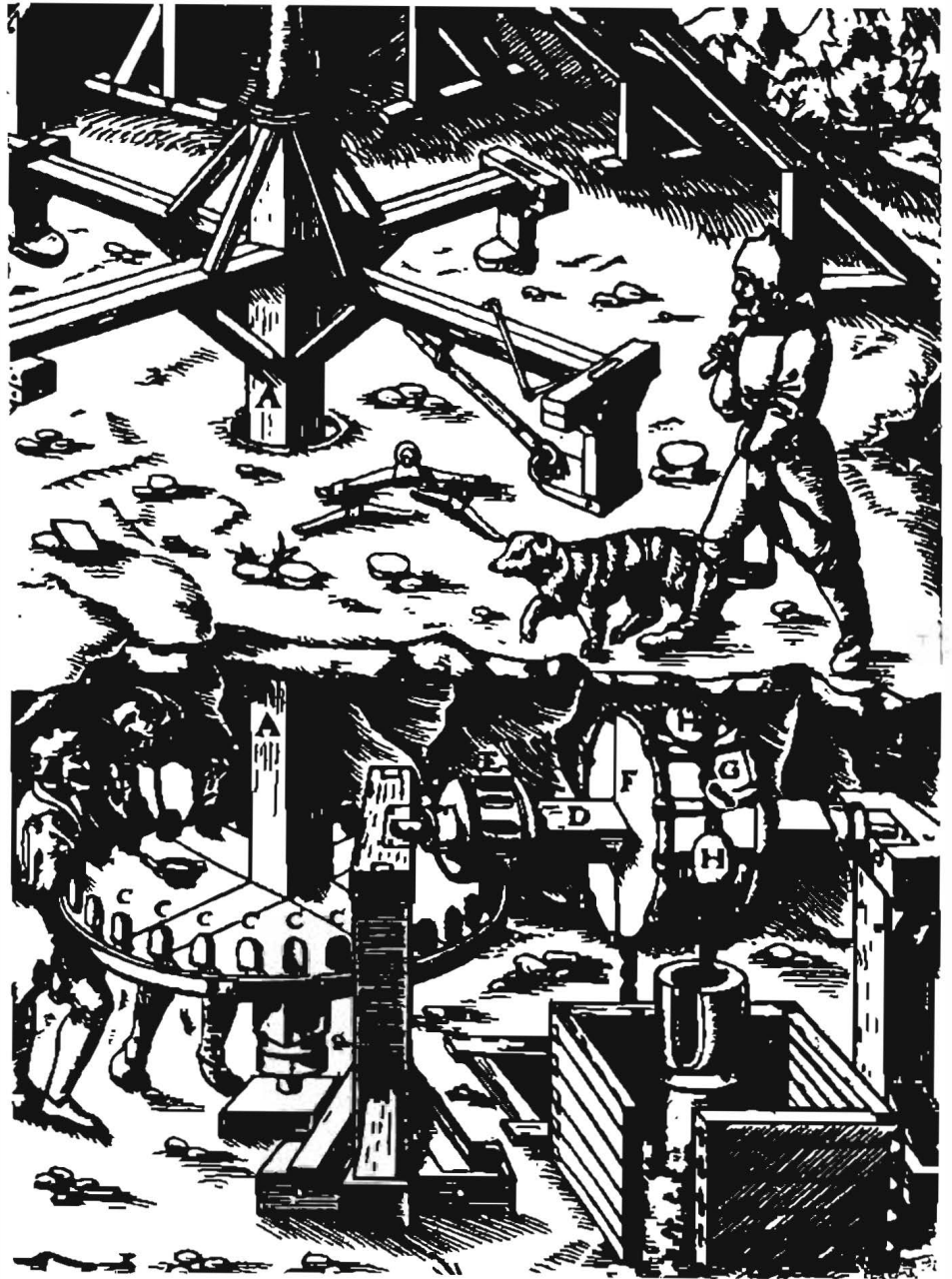
Extracción de agua de una mina. Siglo XVI. G. Agrícola.
