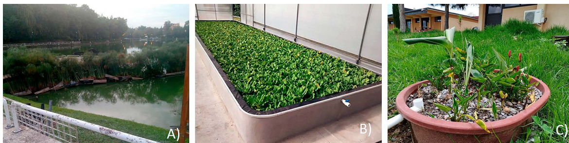
Figura 2. Ejemplos de humedales artificiales en operación, A) humedal a base de plantas de papiro ( Cyperus papyrus ) y pontederia ( Pontederia L. ) para tratar agua del “paseo los lagos” en la ciudad de Xalapa, B) humedal a base de planta lechuguilla acuática ( Pistia stratiotes ) para tratar agua del río sordo en el Instituto de Ecología, AC, ciudad de Xalapa, C) humedal a base de plantas de alcatraz ( Zantedeschia aethiopica ) para tratar agua doméstica en el Instituto Tecnológico Superior de Libres, en ciudad de Libres, Puebla.
