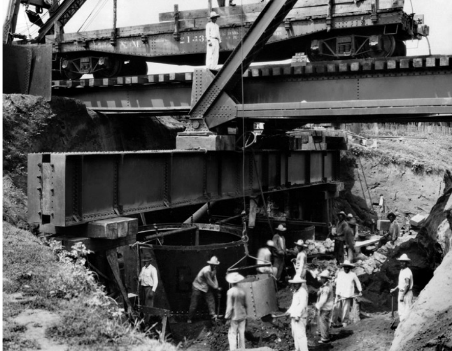
© Cilindros de apoyo para la trabe del puente en el río Tuxtla, 1930. Fondo Comisión de Avalúo e Inventarios. CONACULTA/CNPPCF/MNFM.
