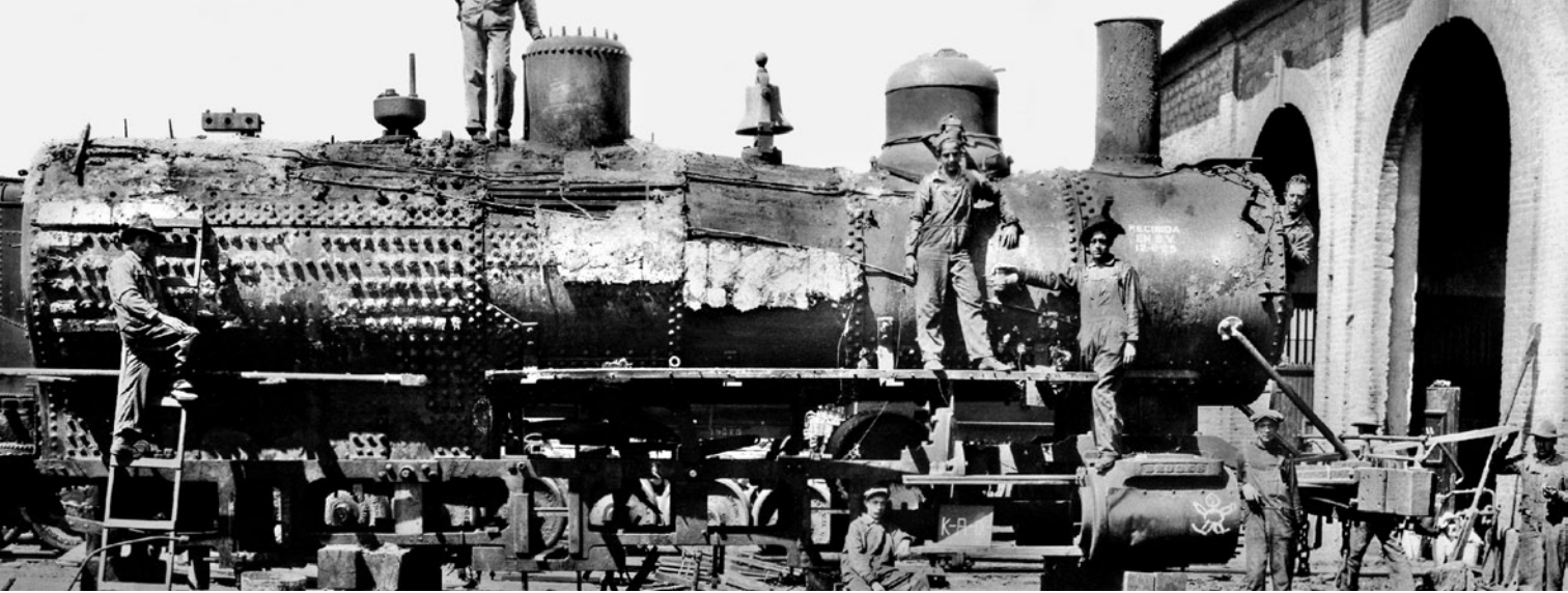
© Locomotora de vapor en reparación, taller mecánico de Buenavista, 1926. Fondo Comisión de Avalúo e Inventarios. CONACULTA/CNPPCF/MNFM.
