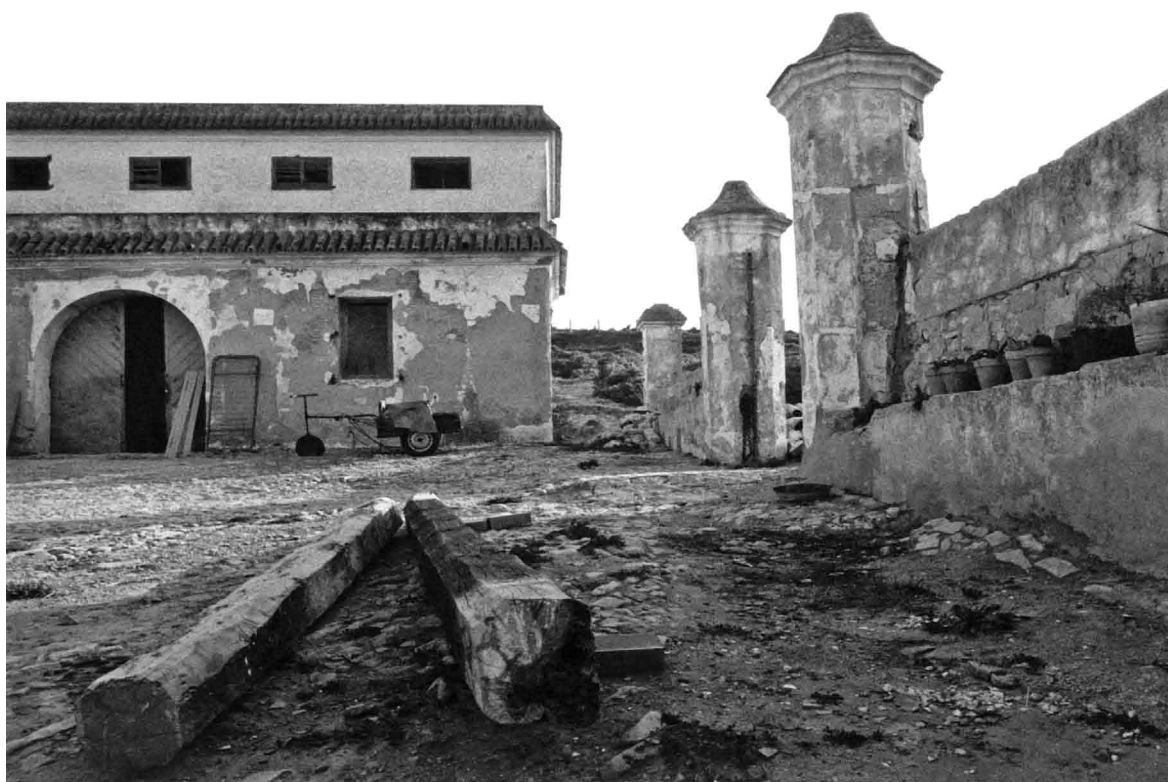
© Ricardo Vinós, En la porquera hay una puerta del poniente que apunta al camino a Chimayó. San Ambrosio. Cádiz, 1993.
