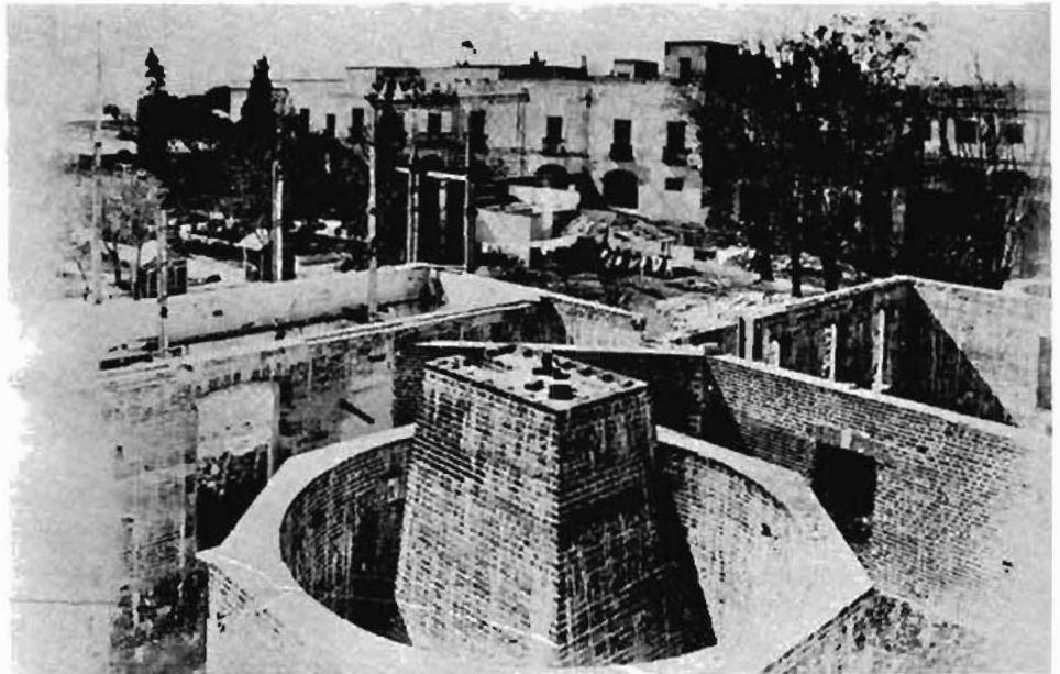
Vista de la construcción del Observatorio Astronómico Nacional de Tambaya. En primer plano, base para el Gran Ecuatorial.
