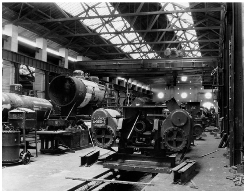
© Taller de reparación de locomotoras en los talleres de Aguascalientes, 1926. Fondo Comisión de Avalúo e Inventarios. CONACULTA/CNPPCF/MNFM.
