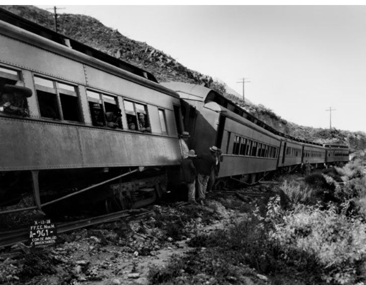
© Descarrilamiento, 1928. Fondo Comisión de Avalúo e Inventarios . CONACULTA/CNPPCF/MNFM. Descarrilamiento, ca. 1940. Fondo Donaciones . CONACULTA/CNPPCF/MNFM. Descarrilamiento, 1928. Fondo Comisión de Avalúo e Inventarios . CONACULTA/CNPPCF/MNFM.
